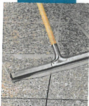
Spoinowanie wyrównanego i wypolerowanego granitu gumową raklą
